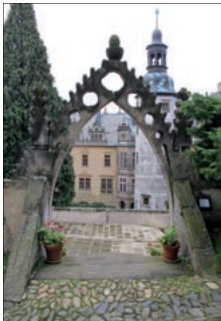
Obr. 31. Stavební proek (schody) omezující vjezd zasahující techniky – zámek Frýdlant
