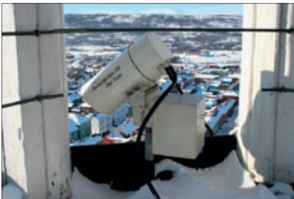
Obr. 56. Speciální termokamera monitorující historické jádro města 84
