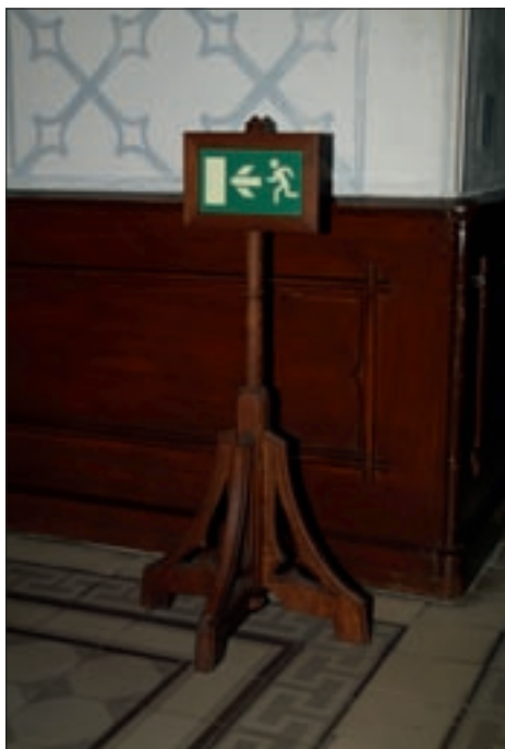
Obr. 77. Samostojná značka únikového východu
