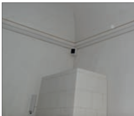
Obr. 43. Lineární optický detektor instalovaný v malé místnosti
