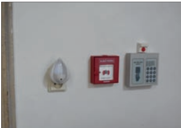
Obr. 33. Instalace tlačítkového hlásiče mezi karetní čtečkou a elektrickou zásuvkou
