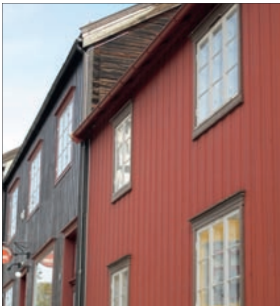
Obr. 54. Venkovní suchovody pro vysokotlaký mlhový systém
