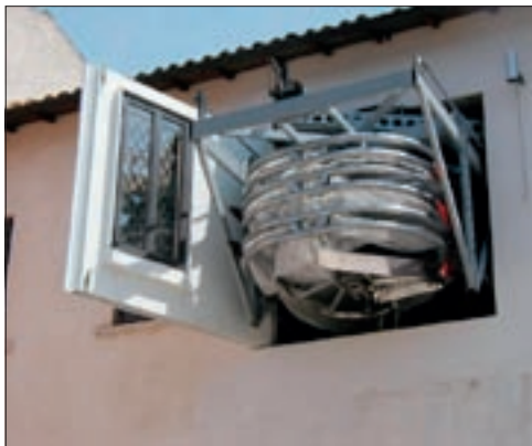
Obr. 76. Výsuvné skládací evakuační schodiště použité v Palazzo Fanzago, Pescocostanzo, Itálie
