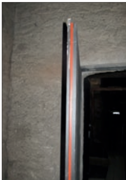
Obr. 65. Klášter Plasý, požární příčky byly ubourány pod střešní konstrukci 15–20 cm, přesto byly osazeny požárními dveřmi – tzv. požárními uzávěry
