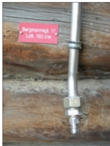
Obr. 16. Připojné místo systému vysokotlaké mlhy na historické budově 44
