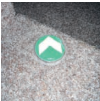
Obr. 78. Značení směru úniku v zátěžovém koberci
