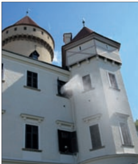
Obr. 15. Ukázka využití vnějšího „suchovodu“ hasiči při námětovém coičení na zámku Konopiště
