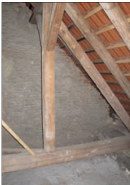
Obr. 65. Klášter Plasý, požární příčky byly ubourány pod střešní konstrukci 15–20 cm, přesto byly osazeny požárními dveřmi – tzv. požárními uzávěry
