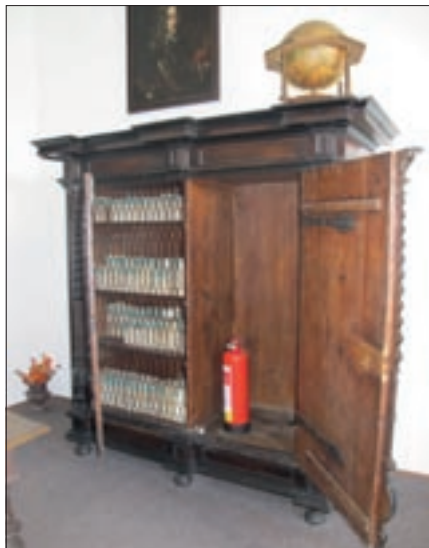
Obr. 28. Umístění ručních hasicích přístrojů v památkových objektech
