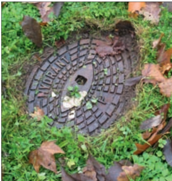
Obr. 11. Podzemní hydrant
