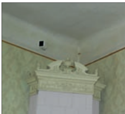
Obr. 43. Lineární optický detektor instalovaný v malé místnosti
