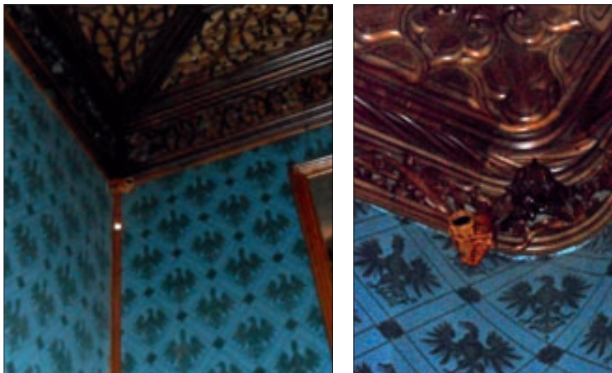
Obr. 45. Instalace detektorů vyzářování plamene ve velmi citlivých interiérech
