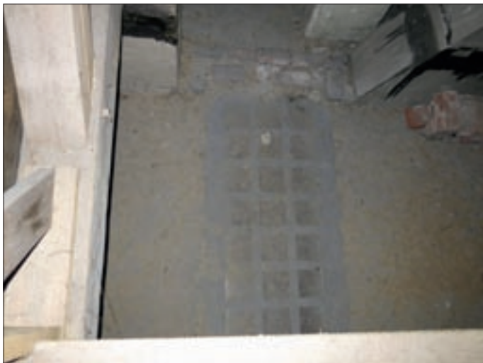
Obr. 62. Zámek Doksany – v podlaze půdy nad chodbou jsou vestavěny luxfery
