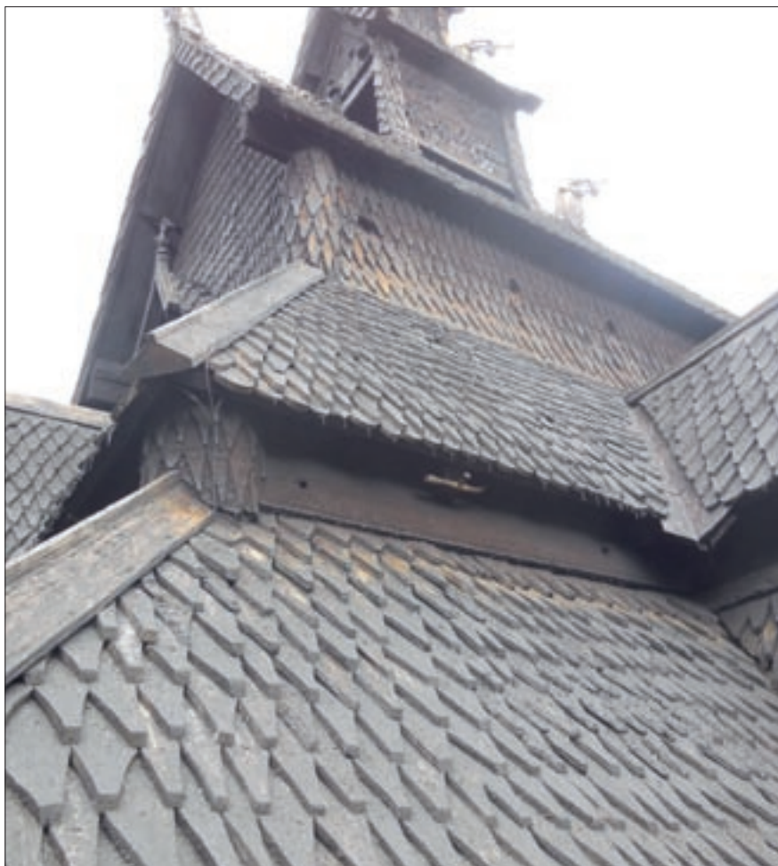
Obr. 35. Instalace lineárního detektoru na sloupovém kostele Borgund v Norsku
