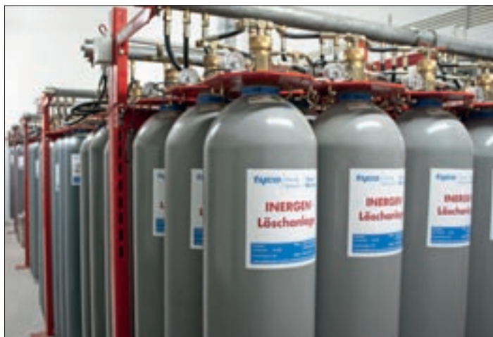
Obr. 58. Tlakové lahve SHZ s Inergenem
