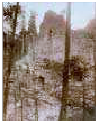
5. Hrad Zbiroh, pohled na severní zeď hradního jádra s kapsami po konzolovém lešení a dosud nepřezděným okenním otvorem. Fotografie před konzervátorským zásahem v letech 1921–1923. Za poskytnutí děkuji T. Durdíkovi.
